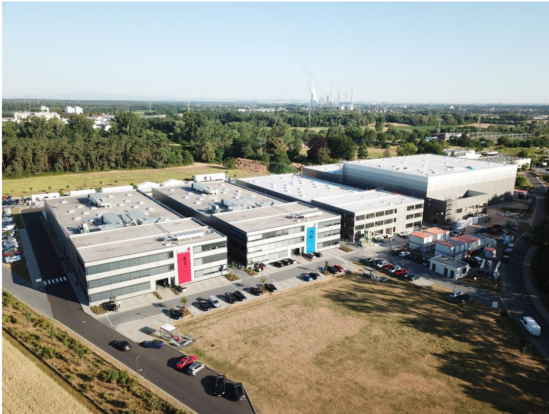
Abbildung: Die Konzernzentrale der BMZ Group in Karlstein am Main, wo derzeit eine dritte Produktionshalle sowie das Logistik Center entstehen (1. und 2. Gebäude v. r.). In „Unit 3“ werden künftig die Batteriesysteme für das JV produziert.
